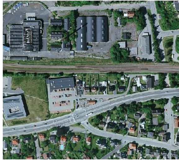
Lufffoto af Br fra 2014. De tre østlige TULIP-bygninger eksisterer endnu, resten af bygningerne er nedrevne, og byggemodning pågår. Østenden af Dyssehøjvej følger spor 1 og ender før underføringen af Truevej .
