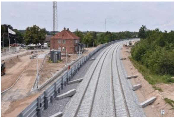
Gz med stationsbygningen og støjskærme. Foto søndag 19. juli 2020.
